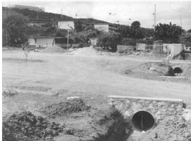
Figura 1 Inicios de la construcción de la Escuela de Ingeniería Civil
