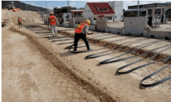
Figura 2 Zanja paralela al paramento y tensado de bandas poliméricas
