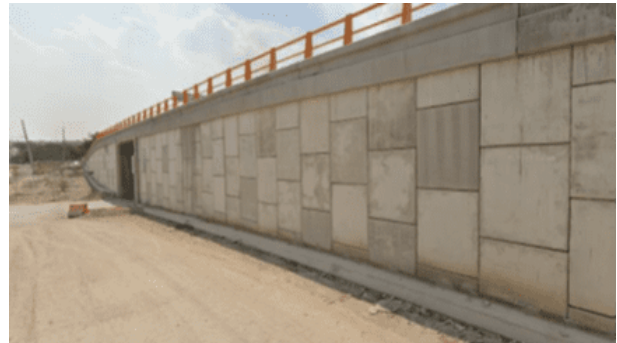
Figura 3 Muro Mecánicamente Estabilizado 2 derecho. Rama 20
